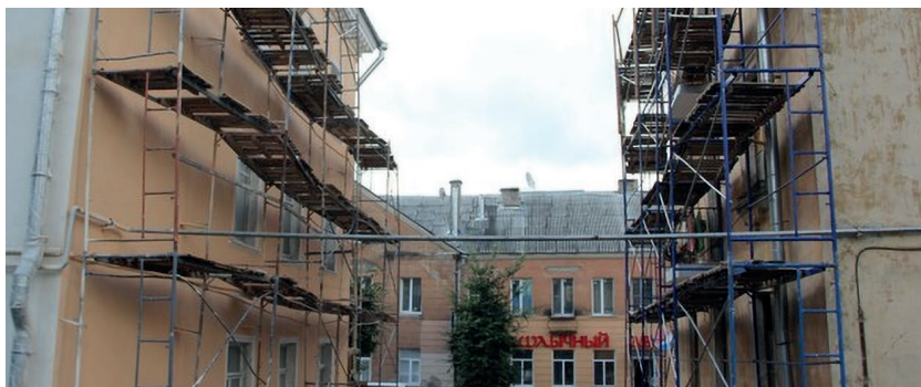
Ремонт фасадов домов позволяет преобразить облик исторической части Пскова ▼
