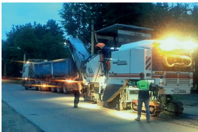
На ремонт участка улицы Советской Армии от трассы Р-23 до Промежиц (протяженностью 2,5 км) израсходовано 21,3 млн Р
