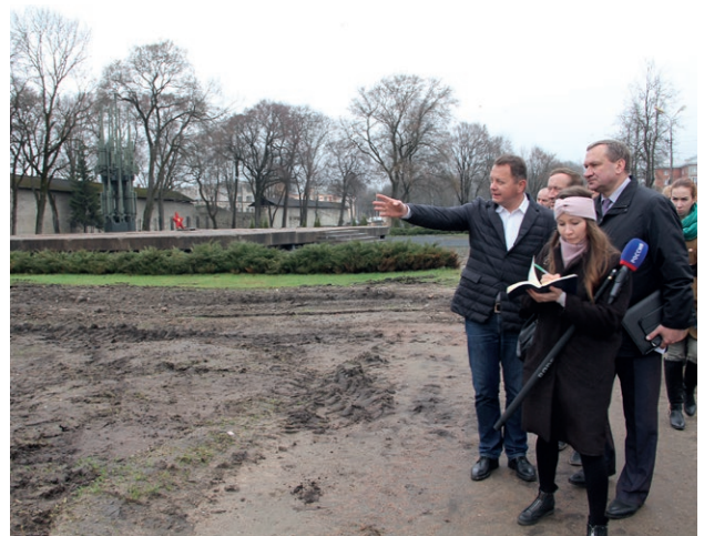
▲ Контроль реконструкции улицы Свердлова и прилегающих к ней парковых зон. Подрядчик обеспечил комфортный подход к мемориалу для церемонии возложения гирлянды в День Победы.
