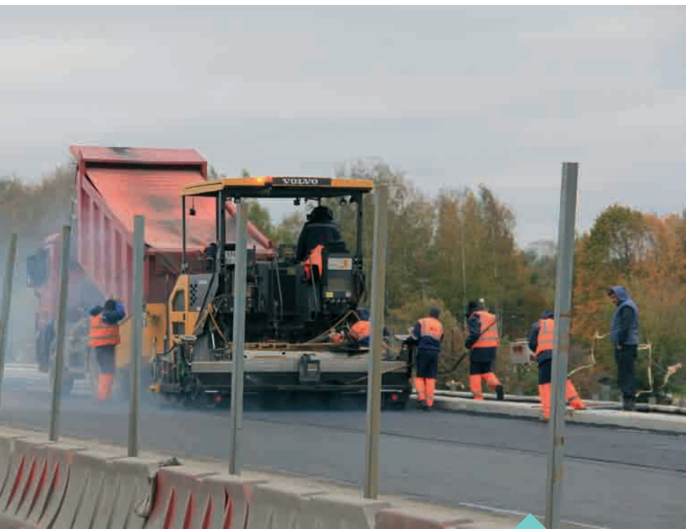
Капитальный ремонт дорог (130,1 млн рублей). Осуществлен капитальный ремонт моста 50-летия Октября. Фактически израсходовано 137,9 млн рублей.
